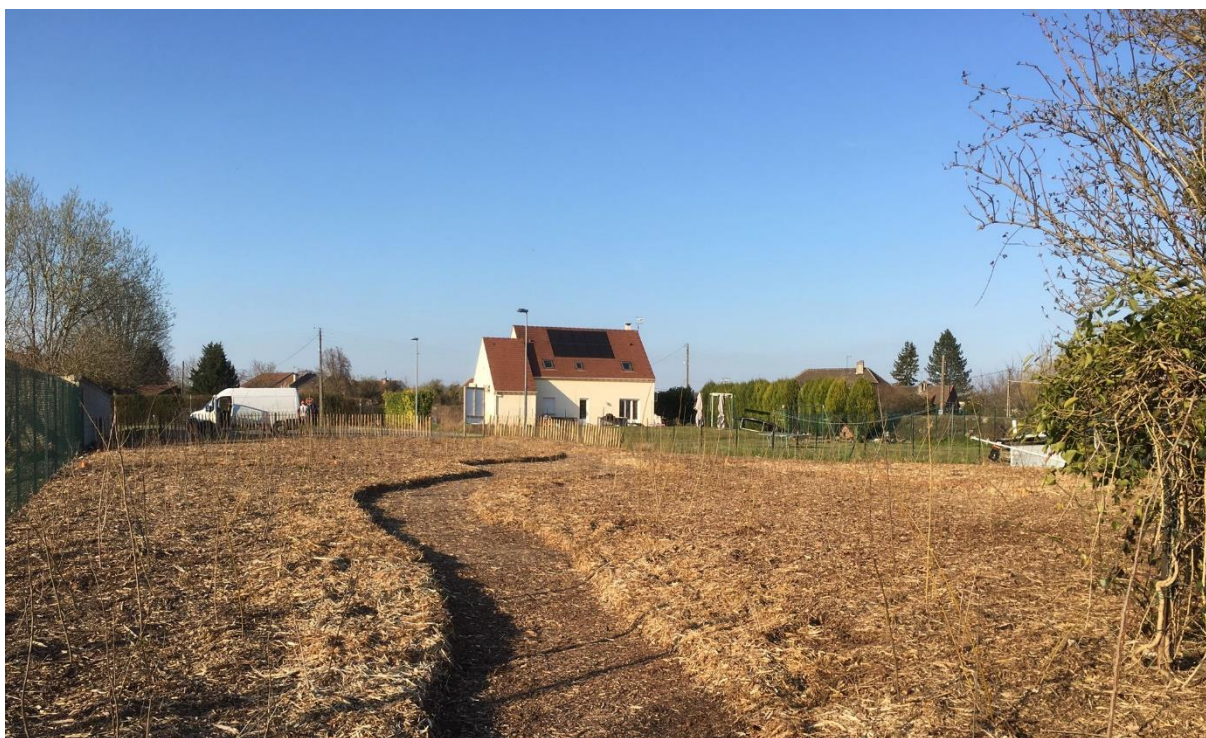
Photo prise par TEW – A la fin des travaux de plantations
